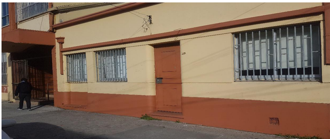
Vías de evacuación calle Salas /al lado de salida principal (4)
